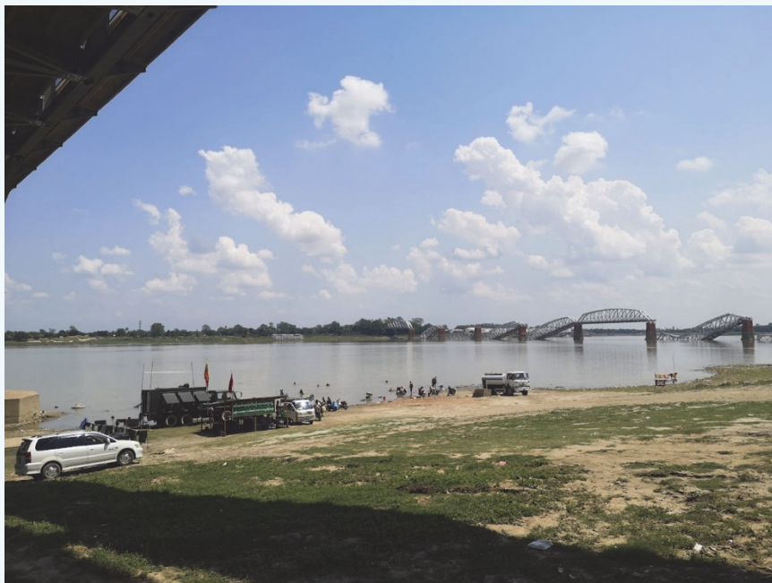
Les ponts de Sagaing en avril 2025.
